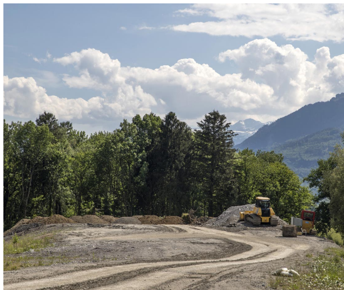
Für zwei Jahre darf der Maurer Aushub nach Eschen gebracht werden. Bild: Tatjana Schnalzer
