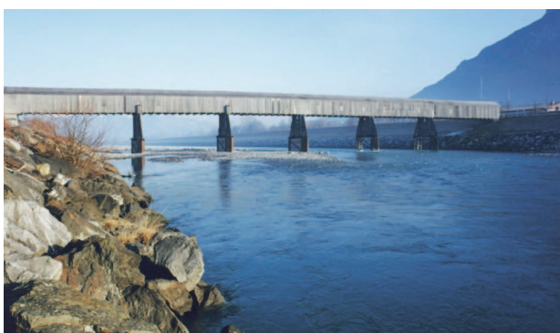
Alte Rheinbrücke; Quelle: Presse- und Informationsamt Fotograf: Close Up, Triesen
