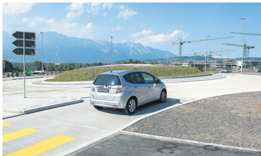
Der neue Kreisverkehr bei der Hilti AG kann seit gestern befahren werden (Foto links), Mitte September soll dann der Strassenabschnitt samt neuem Kreisverkehr bei der Hilcona AG (rechtes Foto) folgen. (Fotos: Michael Zanghellini)
