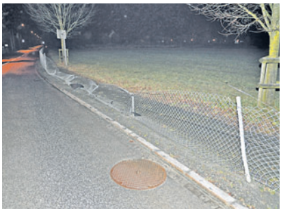
Der Maschendrahtzaun an der Noflerstrasse in Ruggell wurde auf einer Länge von knapp 16 Metern beschädigt. (Foto: Landespolizei)
