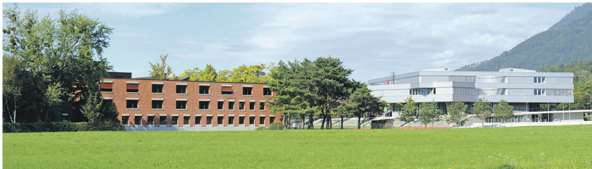
Der G-Trakt des Gymnasiums (links) soll für einen Ersatzbau weichen. Während der Bauarbeiten soll auf dem Mühleholzareal ein grosses Provisorium erstellt werden, in dem Schüler des Gymnasiums wie auch der Sport- und Realschule unterkommen sollen. (Foto: da)
